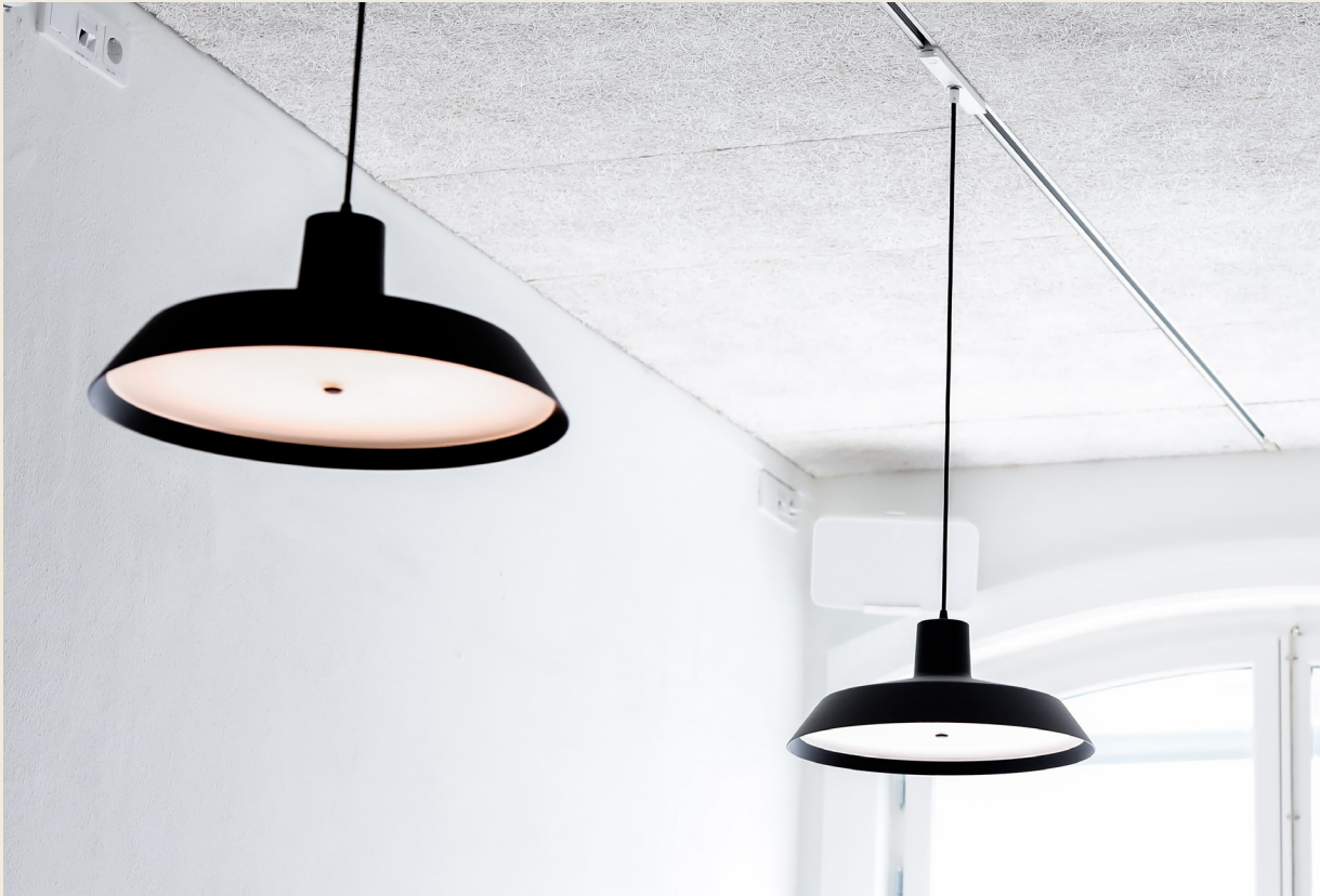
Undertak i träullitplatta
