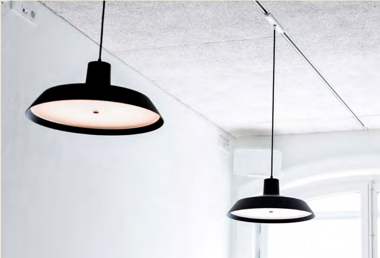
Undertak i träullitplatta
