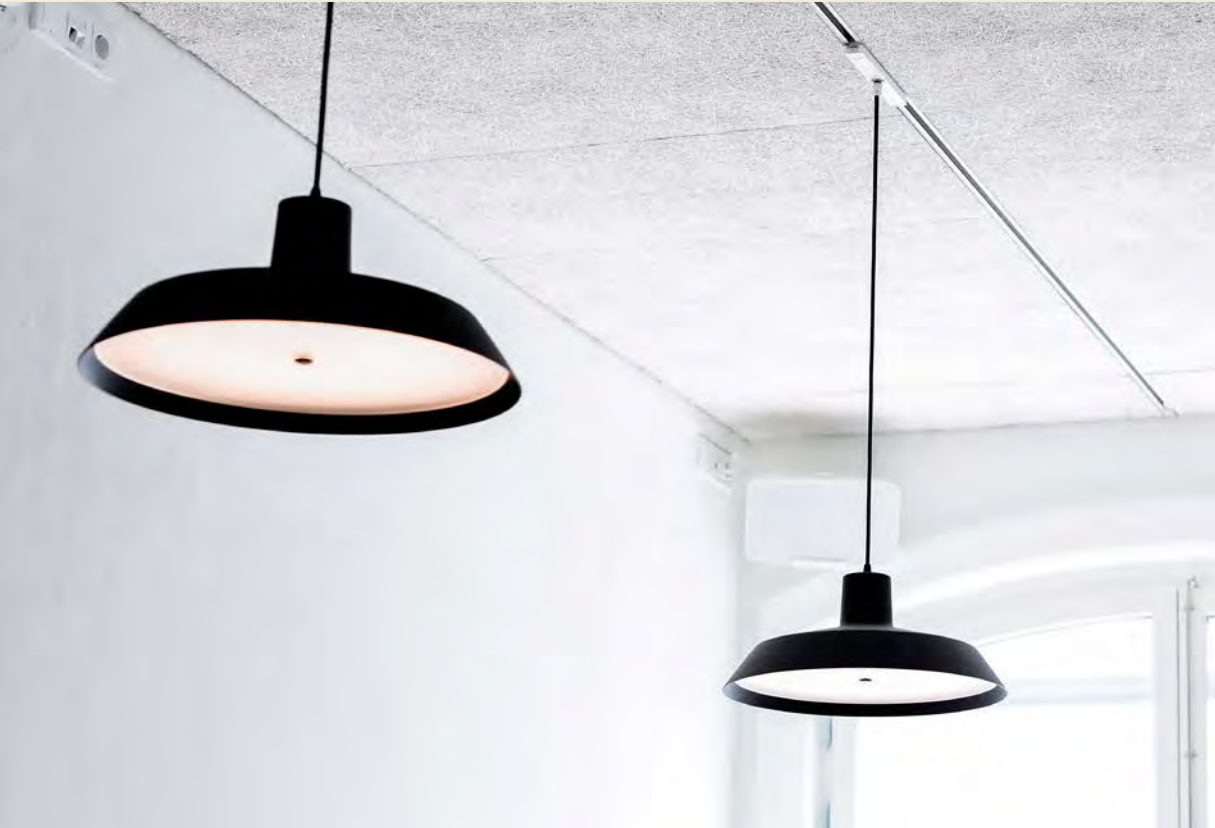
Undertak i träullitplatta
